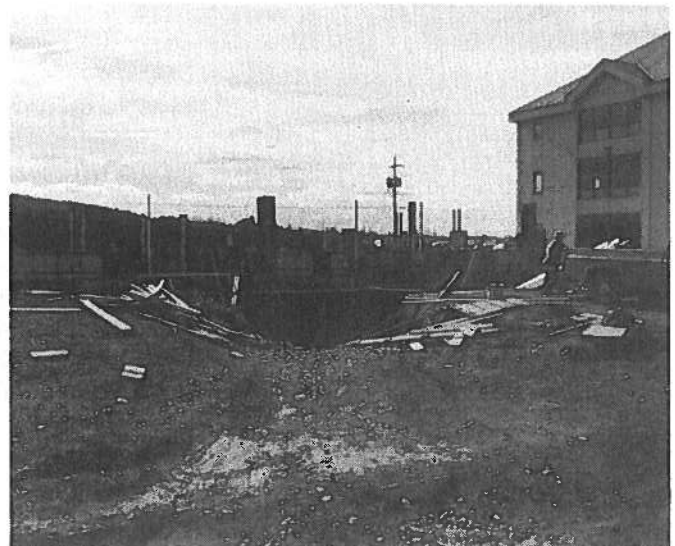
Déjà les travaux avancent. Photo prise le 5 novembre 1990.
